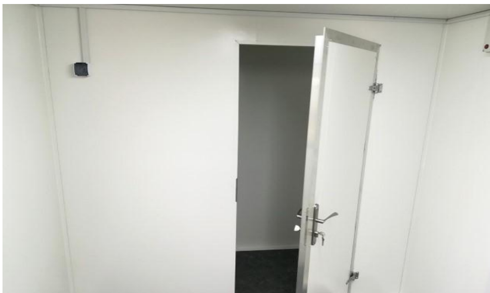
Fotografia nr 12. Ściana działowa
